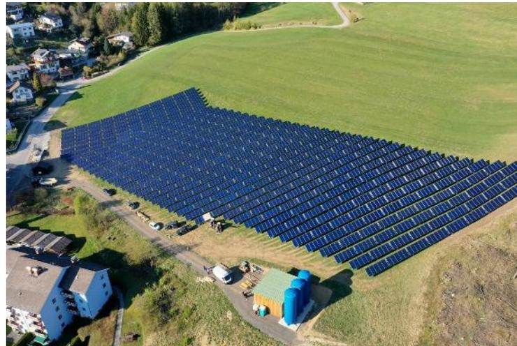
**Солнечное тепло подаётся в поток сети районного теплоснабжения при температуре до 95°C**
